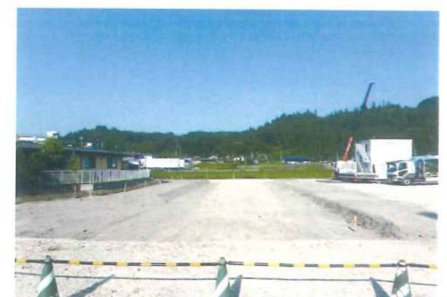
建築施設造成工事 (朝日町発注)
