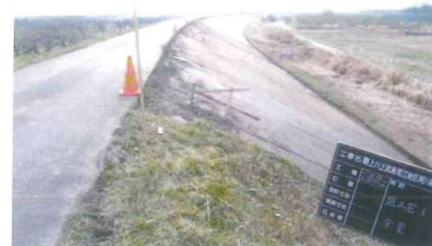
河川堤防工事 (国土交通省発注 天童市地内)
