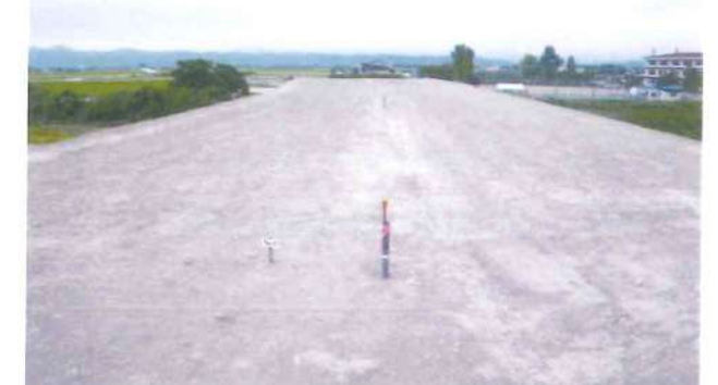
道路改良工事(主要地方道天童大江線) (山形県発注 天童市地内)
