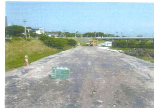
工事用道路築造工事 (山形県発注 山形市内)
